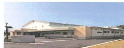
大洲市学校給食センター(愛媛県)
