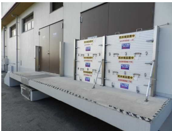
備蓄倉庫への止水板設置（堺泉北港）
