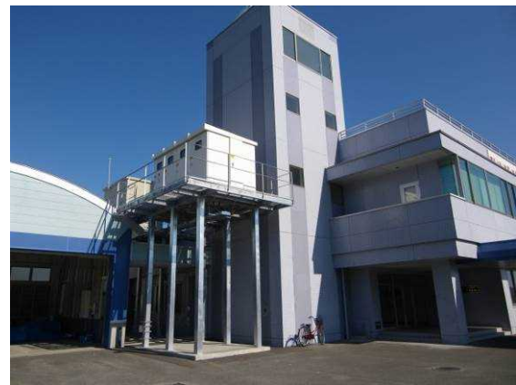
電源設備の嵩上げ（釜石港）
