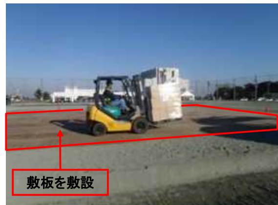
敷板の埋設による作業用地の応急復旧（川崎港）
