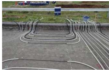
ケーブルを舗装に埋設
