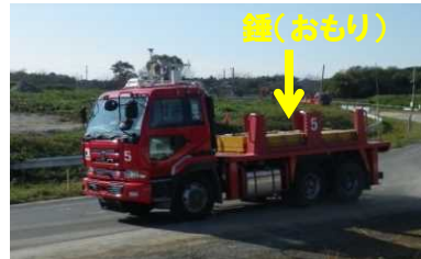
大型車両を走行させ舗装への影響を確認
