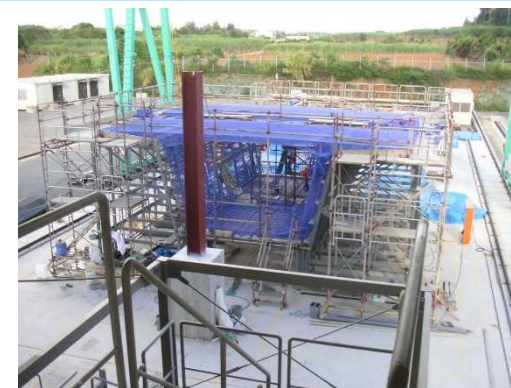
現場でプレハブ化した例 (高所作業の削減)
