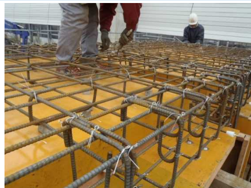
現場の結束作業 (1カ所ずつ手作業) (高所作業の場合もあり)
