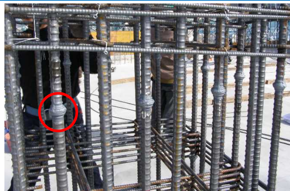
鉄筋をつなぐための圧接作業が必要
