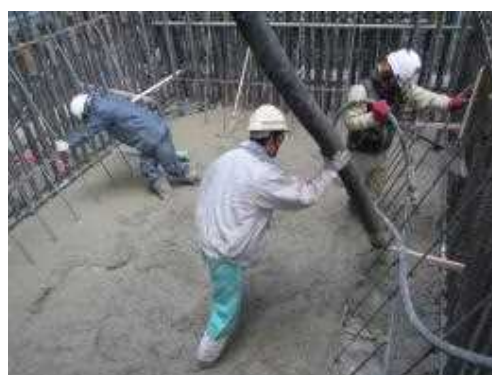
充填不良を防止するための振動締固め作業
