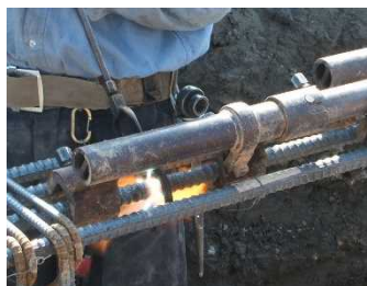
ガス圧接作業 ※天候などの作業環境によって制限を受ける
