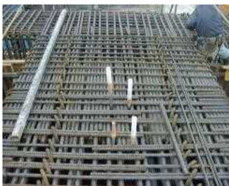
梁部材上筋のあきが確保されず、コンクリートの打込みが困難な事例
