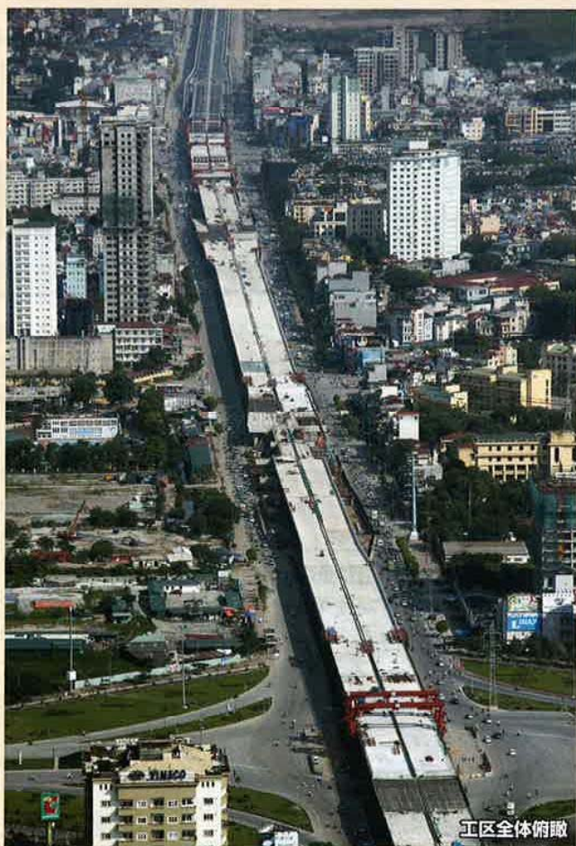
支保工・足場一体化鋼製大型型枠(システム型枠)
