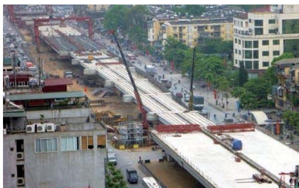
上部工の施工
