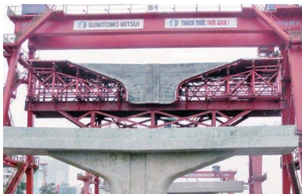
足場・型枠・支保工のシステム化
