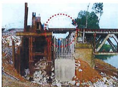
線路の下に橋台を施工する箇所では、5本の古いレールを抱き合わせて補強している
