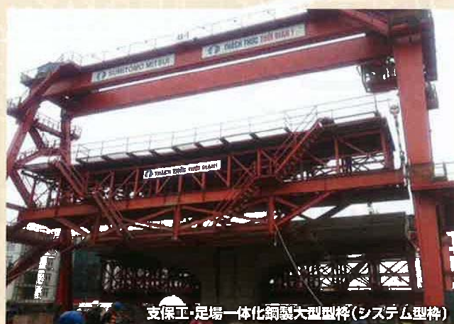
支保工・足場一体化鋼製大型型枠(システム型枠)
