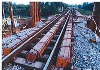
線路の下に橋台を施工する箇所では、5本の古いレールを抱き合わせて補強している
