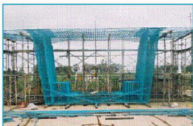
鉄筋のプレファブ化
