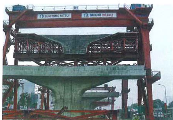
写真-2 支保工・足場・型枠一体化鋼製大型型枠(システム型枠)
