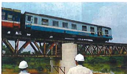
ベトナムの南北統一鉄道は非電化、単線。列車を運行しながら工事が進む。写真はNO.16橋梁
