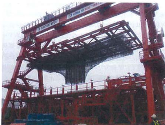
写真-1 鉄筋一体吊込
