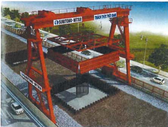
図-3 フーチング施工
