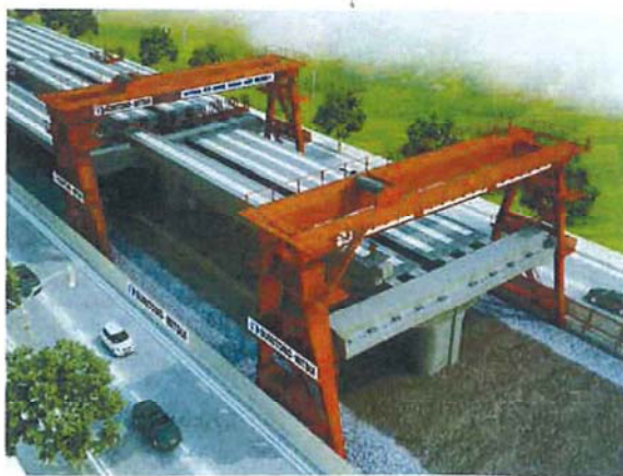
図-7 上部工スーパーT桁架設
