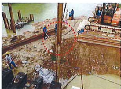
コの字形のシートパイルを背合わせに溶接して「H形鋼」に。以前、鉄建のエンジニアリング本部に所属していた本島工事主任が強度を検証済み
