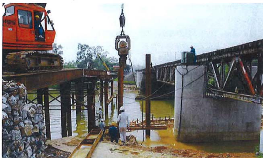
NO.16橋梁では、横取り架設に向けて桁を施工している。重機が載っているのは仮設の棧橋だ
