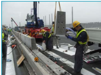
プレキャスト壁高欄（橋面工）
