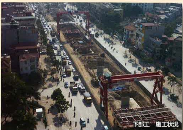
門型クレーンの相吊りによるPC桁架設工
