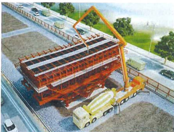
図-6 脚頭部コンクリート打設工
