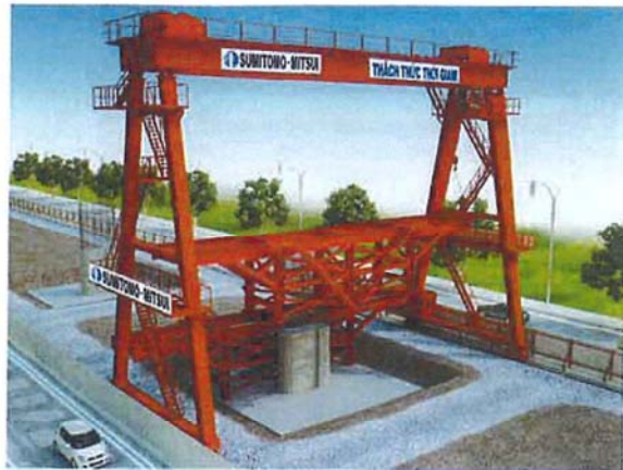
図-5 脚頭部施工(作業台)
