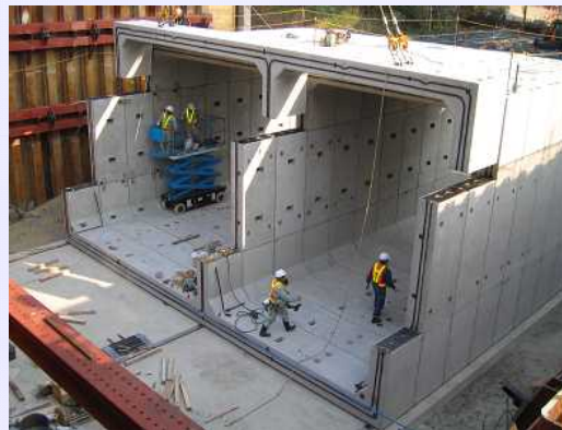
2連式(5分割)ボックスカルバート (内幅)5500+6580mm(内高)5400mm
