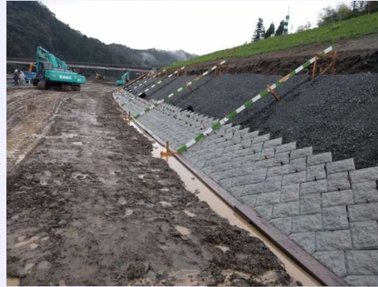
小型積ブロック平張例 450mm × 300mm
