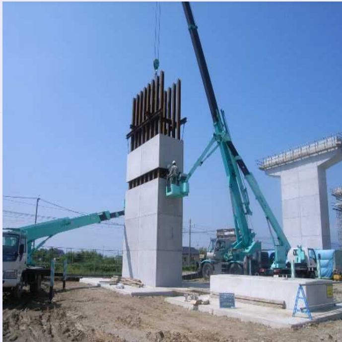
橋脚の急速施工
