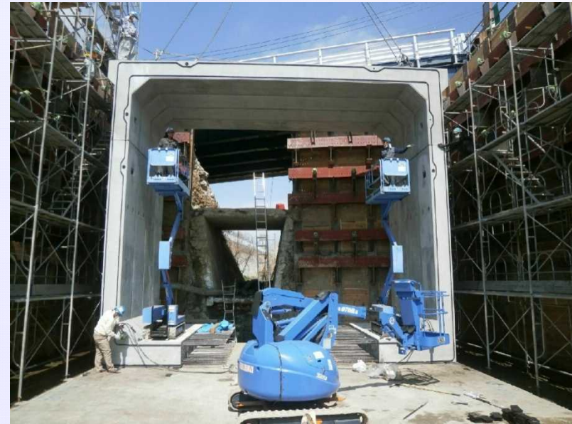
低所工事で施工しやすい底版は現場打ち
