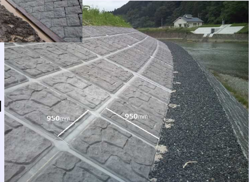
大型平張ブロック例 950mm × 950mm
