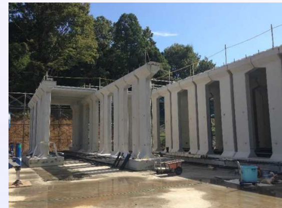
地下調整池を、部材をつなぎ合わせて組立
