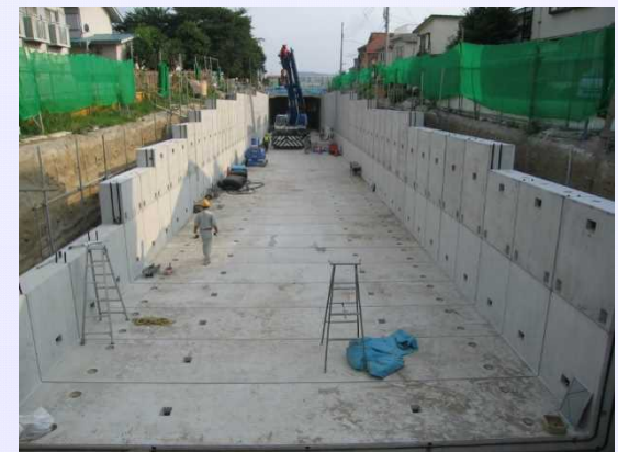
アンダーパスを、部材をつなぎ合わせて組立
