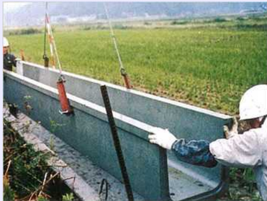
5mの側溝で据付
