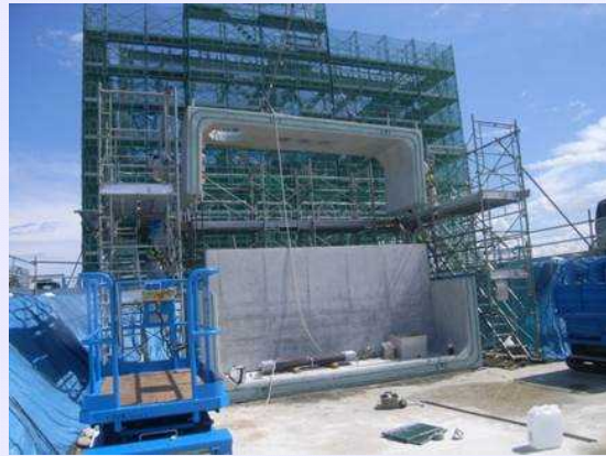
貯水槽を、躯体部から越流壁および端部壁の全部材をプレキャスト化
