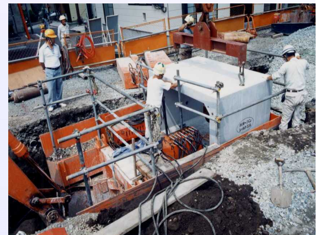
矢板を打たずに前面に推進機械を設置するBOX敷設(移動式簡易土留め工法)
