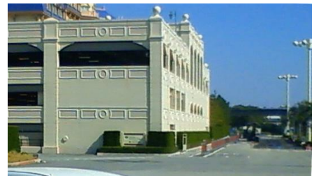
写真-1 A建物の地震直後の状況 (2011.3.13撮影)
