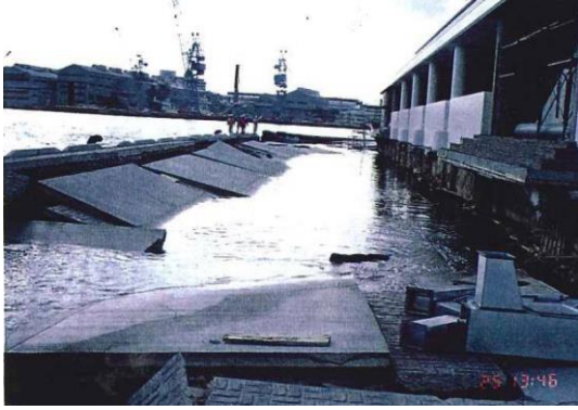
写真-2 埠頭の南側岸壁の被害
