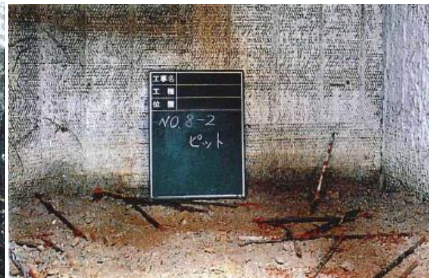
写真-5 建物地下ピット(2) (壁に立てかけられた鉄筋の状況)
