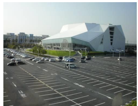
写真-2 B建物の全景 (2011.5.18撮影)
