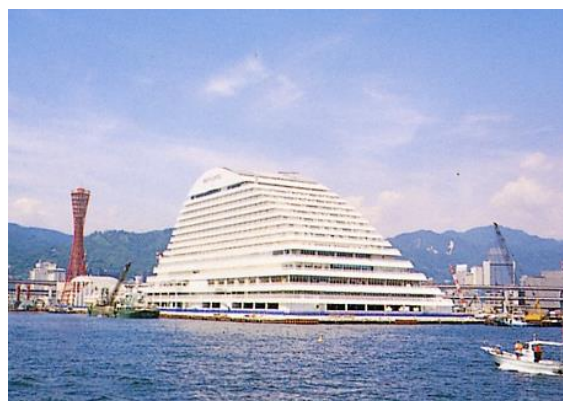
写真-1 建物全景
