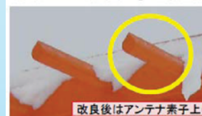
改良後「ANT形状見直し」「塗装塗料変更」
