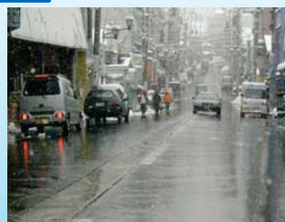
下水処理水を活用した消雪
