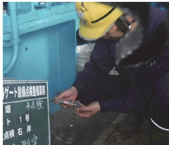
図3 ギヤのバックラッシの計測方法
