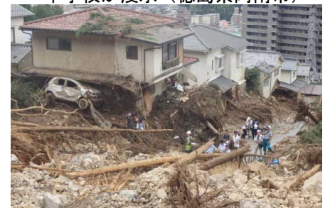
土砂災害による甚大な被害 （広島県広島市）
