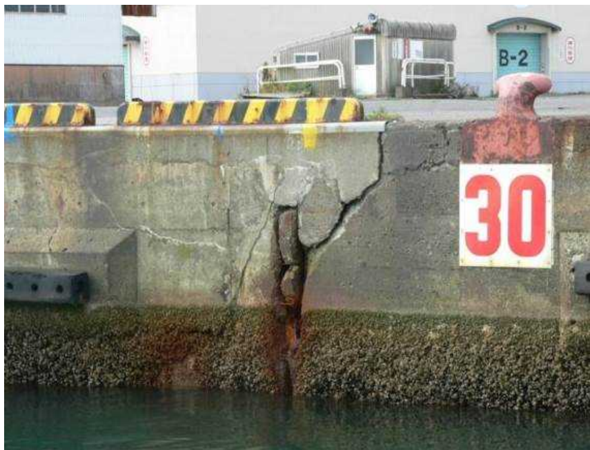
図－9 耐震強化岸壁の老朽化事例
