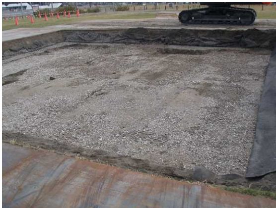
緑地の下に砕石埋設（川崎港）
