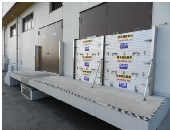
備蓄倉庫への止水板設置（堺泉北港）
