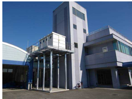
電源設備の嵩上げ（釜石港）
