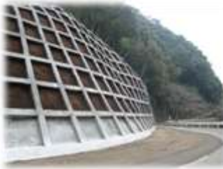
▲道路法面の防災対策
