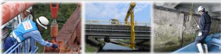
▲橋梁の近接目視点検
