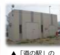
▲「道の駅」の非常用電源装置
