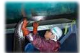
▲炭素繊維シートによる床版ひび割れ対策
