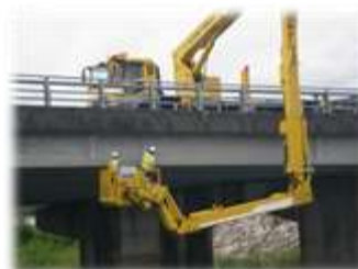
▲高所作業車による定期点検
