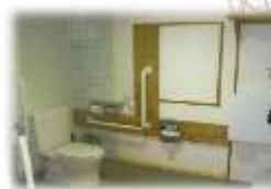
▲ 遍路道周辺に 多目的トイレを設置
