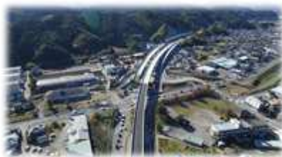
▲主要幹線道路の整備（高知松山自動車道）
