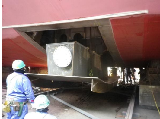
吹き出し部船体切り替え工事
