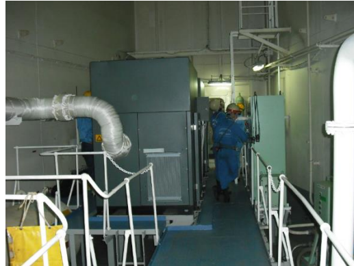
ブローおよび制御盤据付完了
