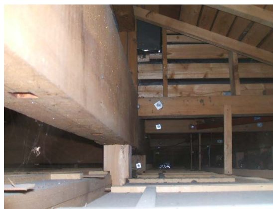
写真 8 現地調査（小屋組の目視確認）
