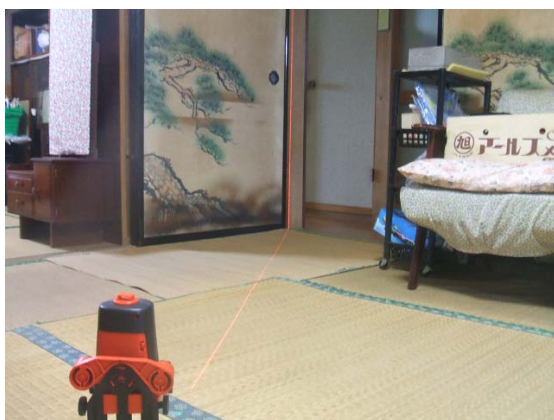
写真 7 現地調査（柱の傾きの計測）
