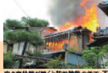
空き家状態が続くと防災機能の低下・不法侵入、場合によっては火災に繋がる危険もあります。
