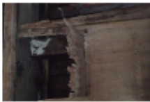
シロアリ被害、家の傾斜の原因になります
