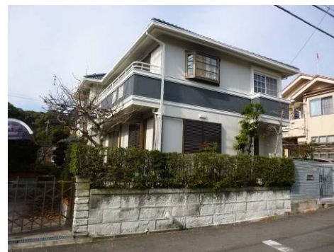
城東団地：よく管理された空き家
