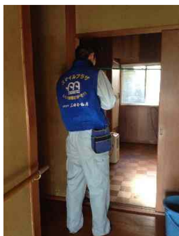
写真1 ユニフォームを着用して作業
