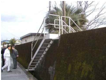
陸閘を廃止し、近接した場所に階段を設け、利便性を確保している事例(潮江地区)
