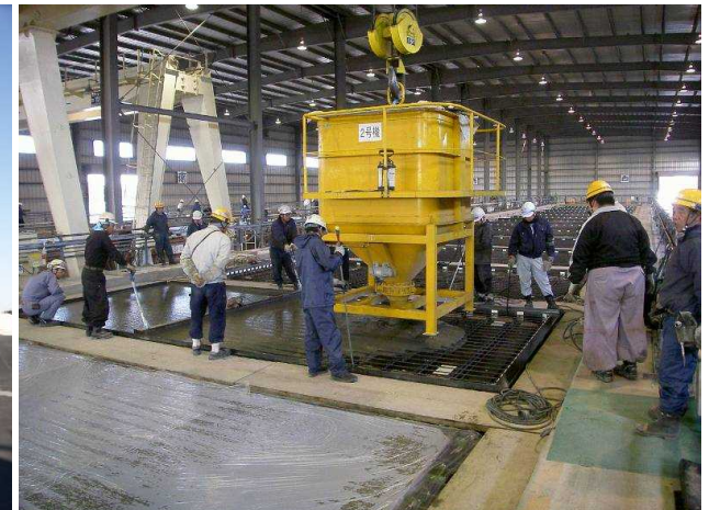
UFCの打設状況
