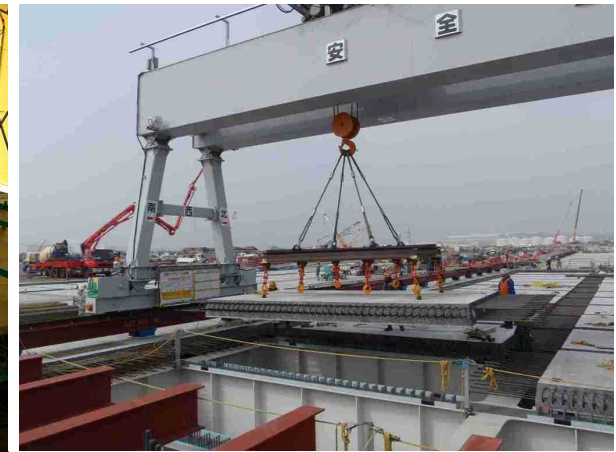
PCa床版の設置状況
