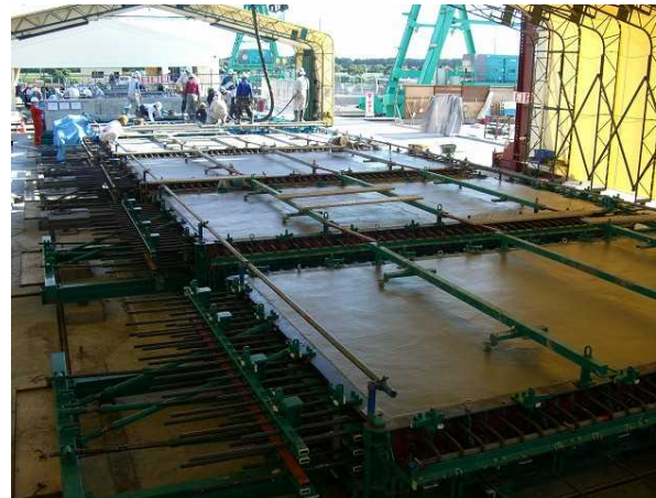
PCa床版の製造状況
