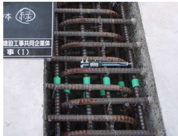
ループ鉄筋継手
