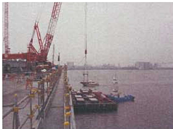
PCa床版 台船から 棧橋上への荷揚状況
