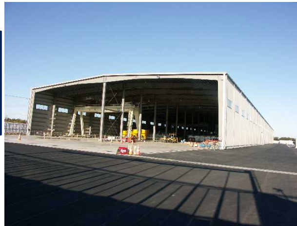
UFC床版製造工場
