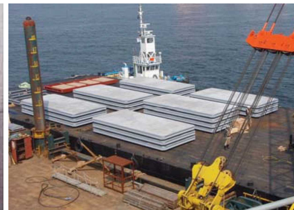
UFC床版 台船に よる海上運搬状況
