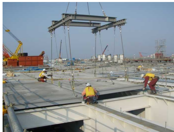
UFC床版の設置状況
