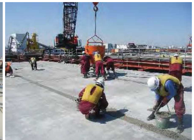
目地コンクリート打設状況
