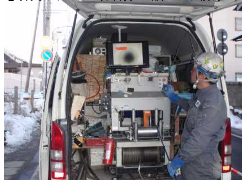
④管更生内面検査
