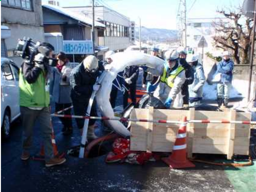
①採熱パイプ 架橋ポリエチレン管 10Φ×14本挿入
