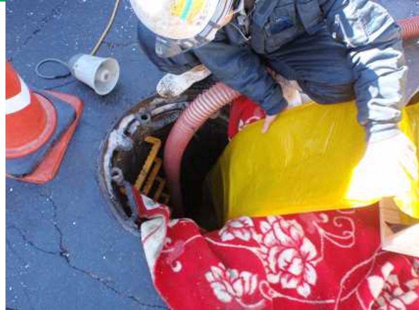
②管更生ライナー材料挿入(膨らます前)
