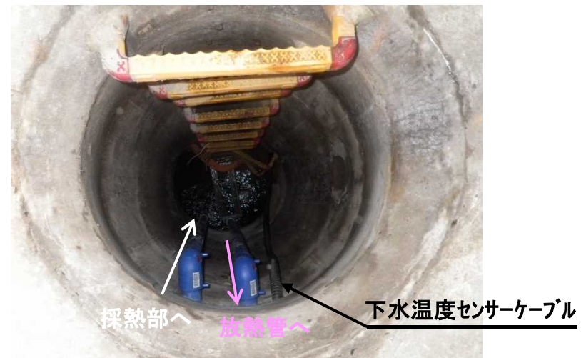
④ マンホール部配管状況
