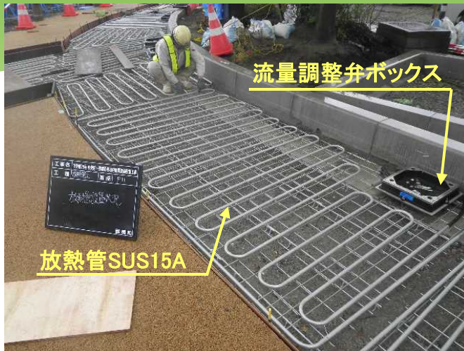
① 放熱管（舗装前）
