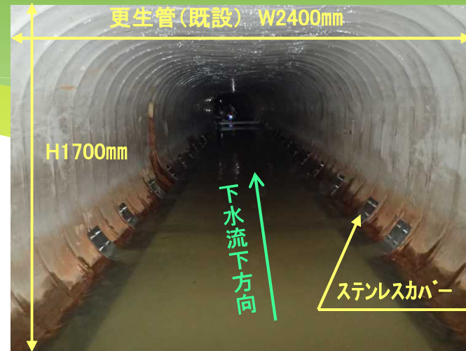
② 採熱管設置後
