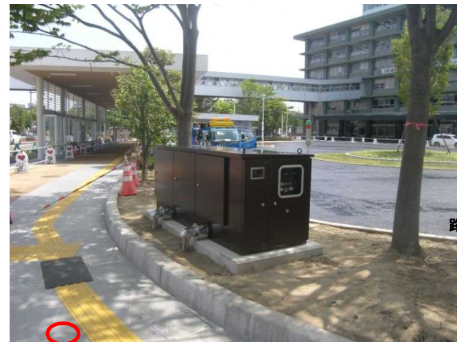
③ 制御盤一体型バルブボックス
