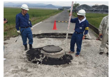
下水管の調査の様子
