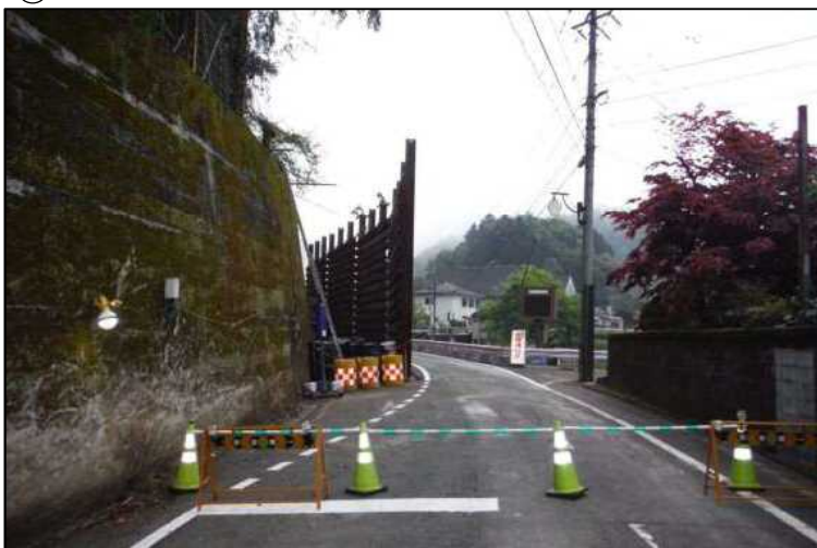
[応急復旧状況]
