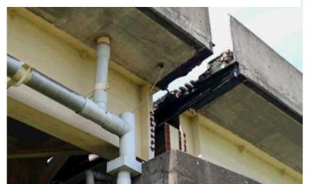
桁のずれ(開き 約30～40cm)
