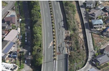
盛土法面の崩落(崩落延長約30～40m)
