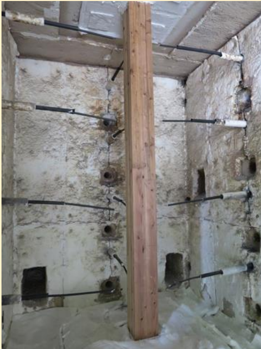
柱試験体 L 3.5m 試験体数: 2体 (集成材, 製材) 部材間の隙間 0mm
