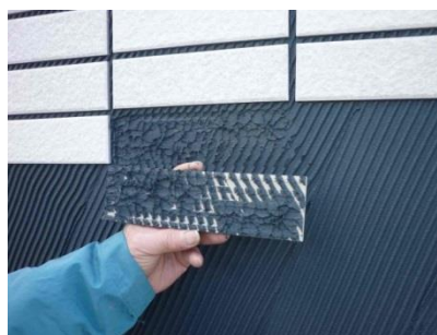
写真1. 2 有機系接着剤張りの付着状態(40%以下の空隙まで許容されている)
