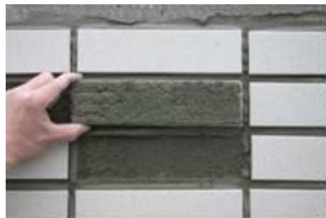
写真1. 1 モルタル張りの付着状態 (90%以上付着している ことが目安)
