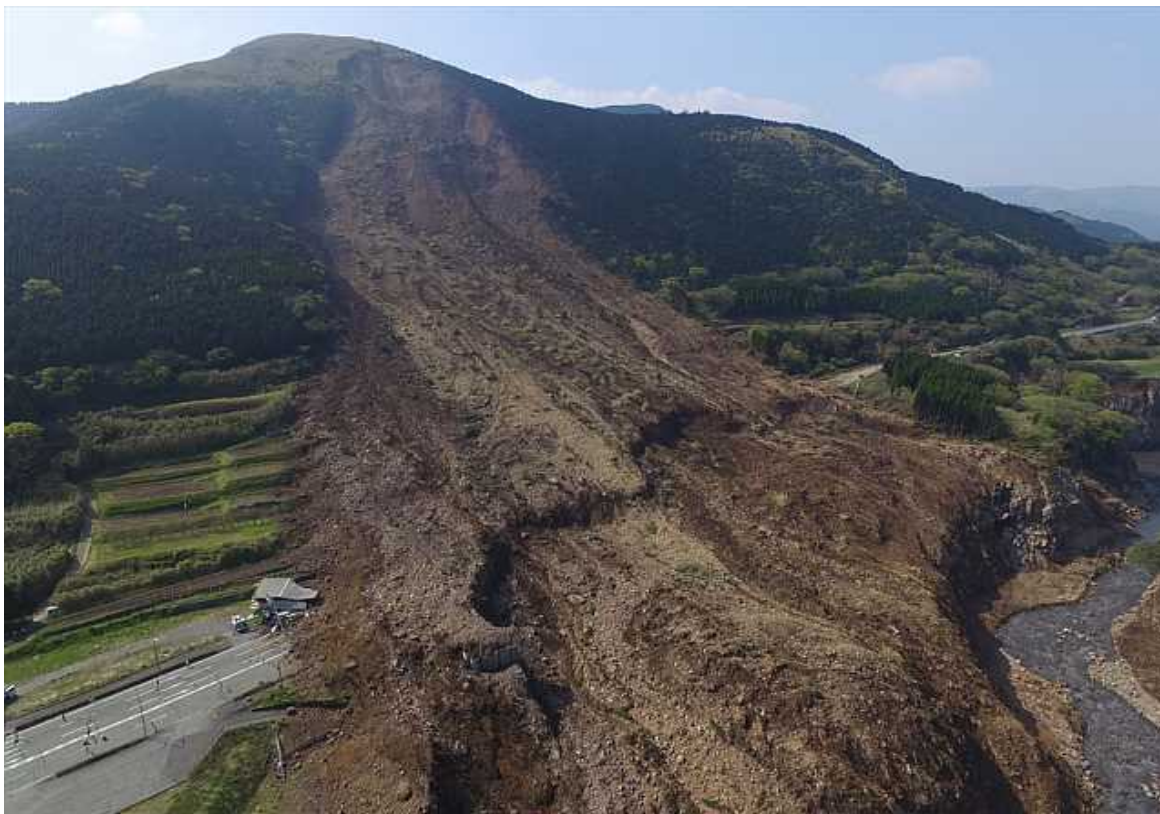
阿蘇大橋地区斜面崩壊(空撮)
