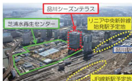
芝浦水再生センター上部利用 事業(東京都下水道局)
