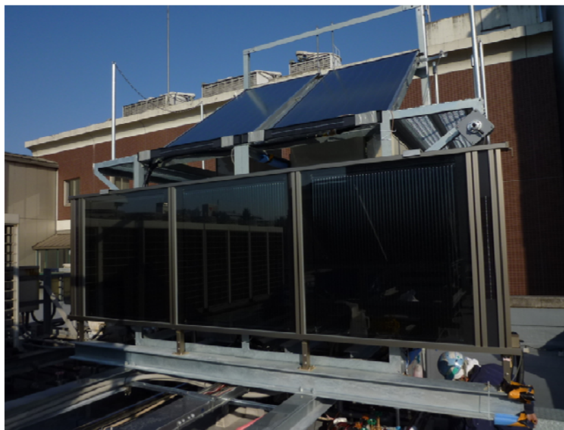
東京大学屋上における設置状況
