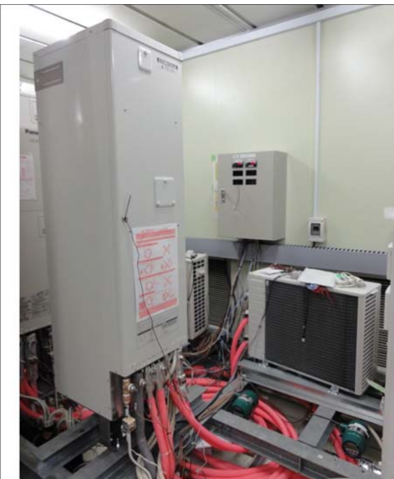
東京大学 人工環境実験室
