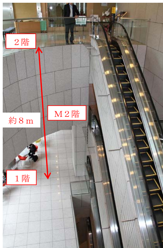
写真1. 事故が発生した吹抜け部分
