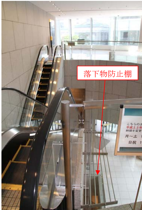
写真3. 落下物防止柵
