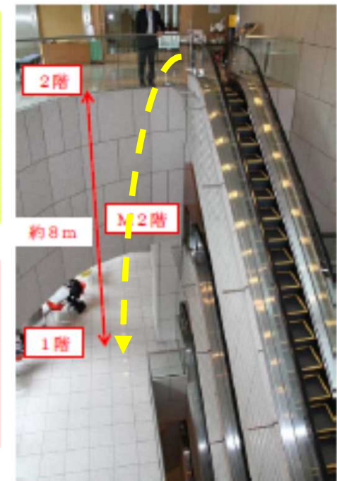
写真1. 事故が発生した吹抜け部分
