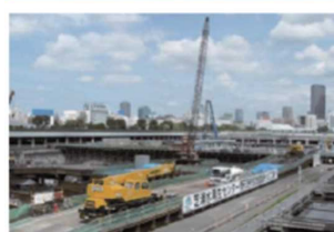
施工状況(平成24年8月)
