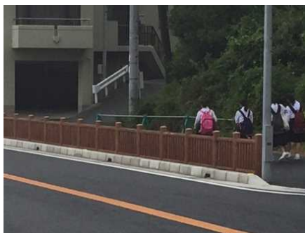
(道路) 国道 28 号 (兵庫県淡路市) : 木製の歩行者自転車用柵
