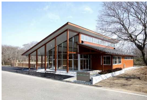
(公園) 国営常陸海浜公園 (茨城県ひたちなか市) : 自然観察施設棟
