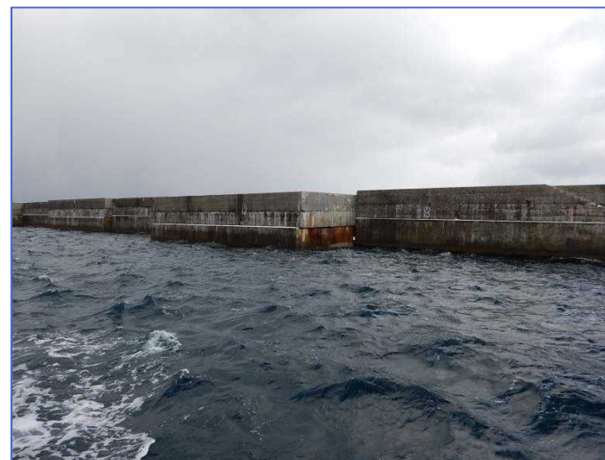
ケーソンの港内側への滑動
