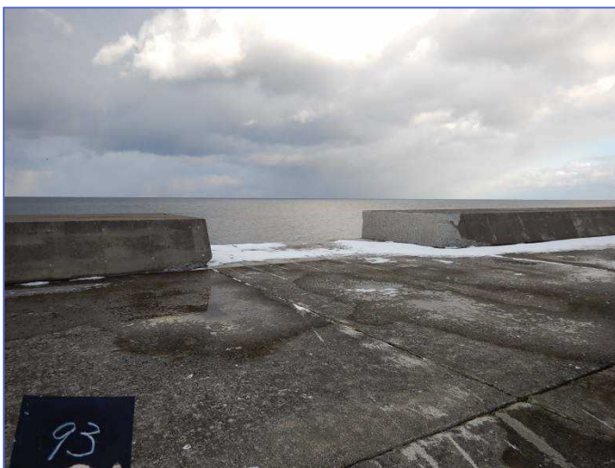
上部工の欠損
