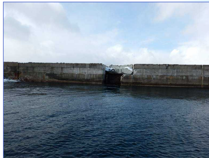
ケーソン・上部工の損壊
