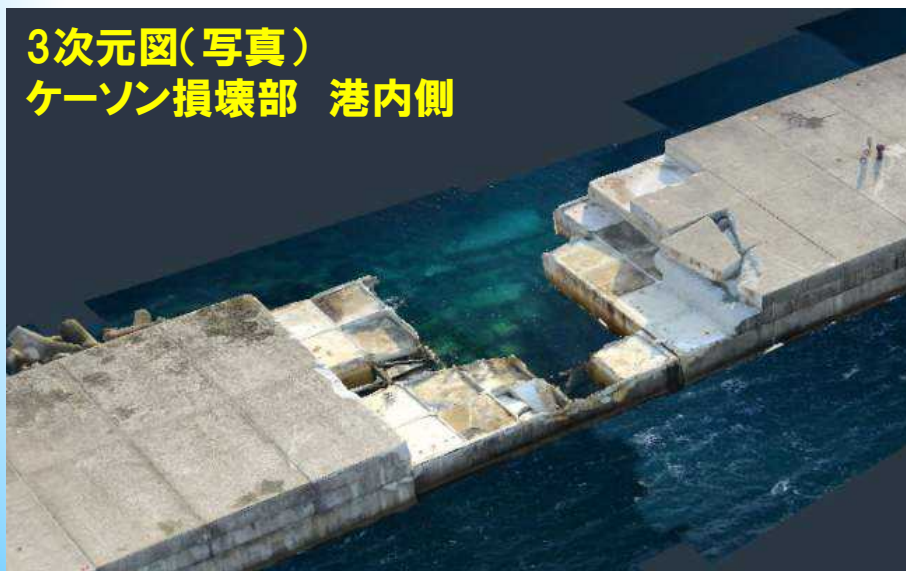
3次元図(TIN) ケーソン損壊部 港内側
