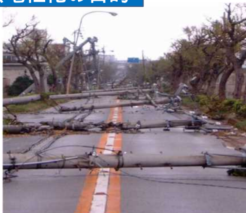
< 電柱の倒壊による道路閉塞 >
