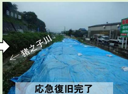
○猪之子川の破堤箇所(L=14m)の応急復旧に23日15時に着手。本日午前中に完了。
