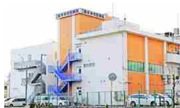
増改築後の藤井寺市民病院、左側の白い棟が増築された新館
