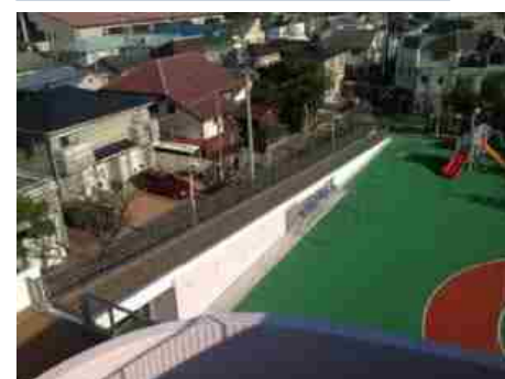
外部からの避難用スロープ
