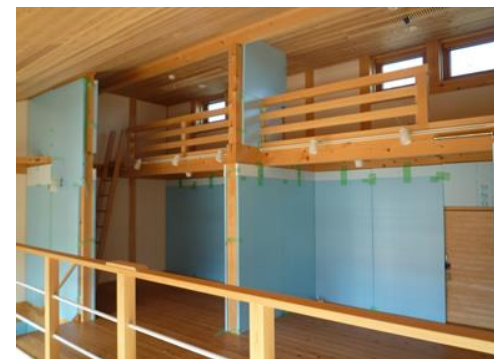
断熱材で覆った後(熱容量小)
