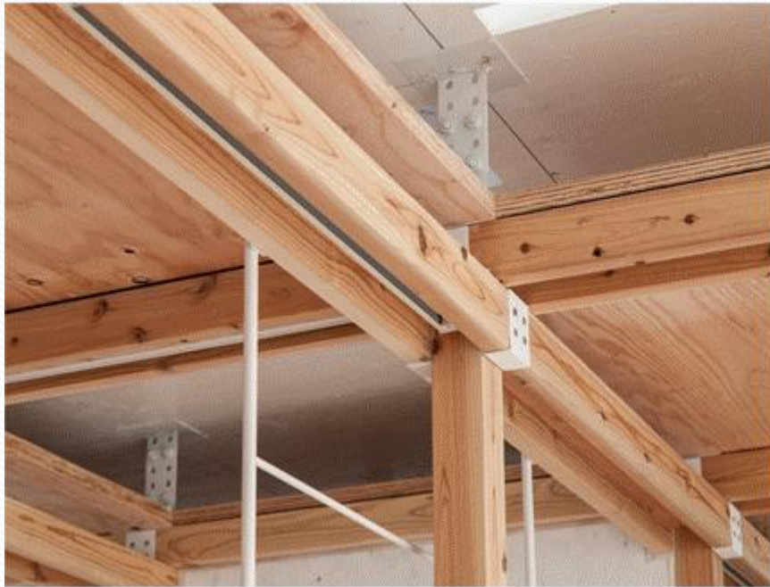
解体可能な柱梁接合金物
