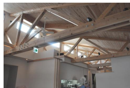
排煙の役割をする南側の光窓
