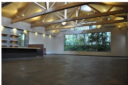
幅5mの開口と11mの大スパン
