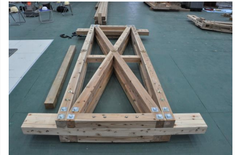
添え胴差しに耐力壁の交差材と同じ100角を用いた。写真下は胴差し。
