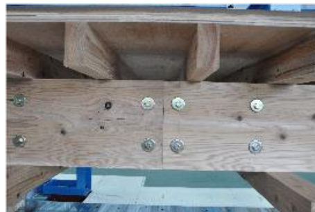
想定荷重では部材間の開きはみられなかった。大梁を上下ではさんだ合成床の有効性を確認。
