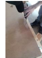
※パネル作製と施工例
