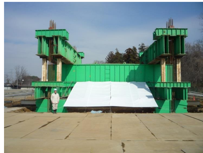
原位置載荷試験(実大杭)
