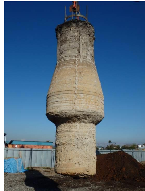
掘り出し調査
