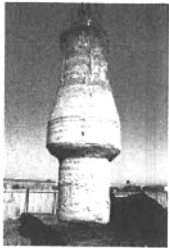
掘り出したMe-A杭
