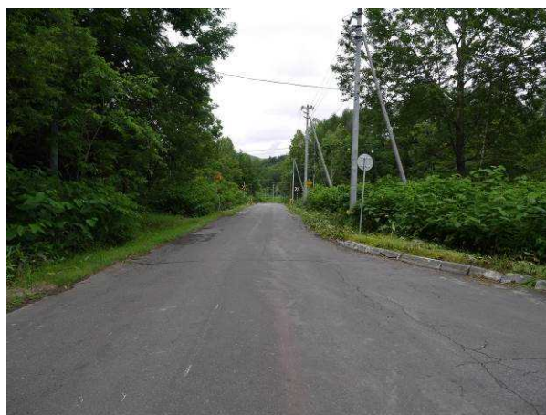
写真－５ 町道恩根内線の様子
