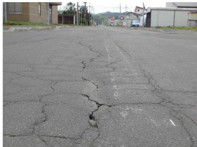
写真－3 路盤劣化の状況（町道7線道路）
