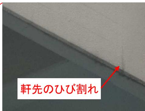
軒先：仕上り材の劣化、ひび割れが発生している。
