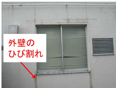
外壁：劣化により、ひび割れが発生している
