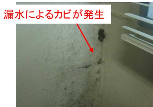
内壁：外壁ひび割れによる漏水及び仕上げの劣化が見られる
