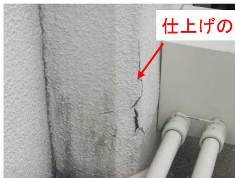
外壁：仕上りの剥離が発生している
