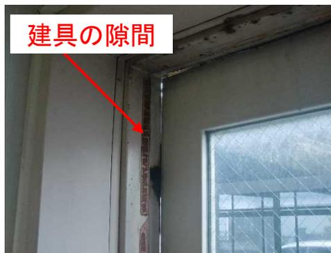
建具：経年劣化により建具に開閉不良が発生している
