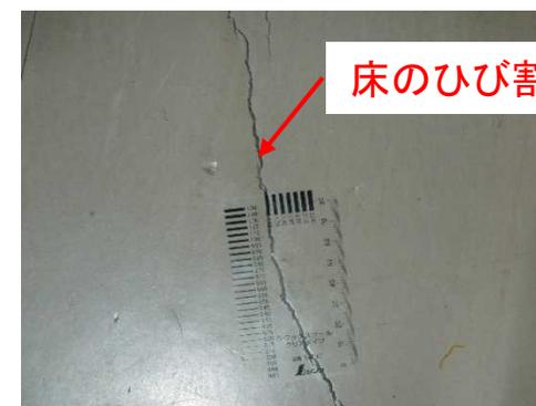
室内床：ひび割れや仕上げの劣化が見られる
