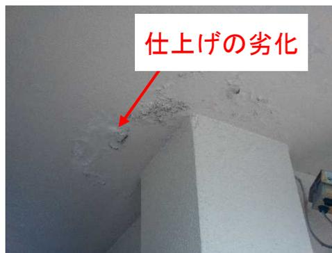
外部仕上げ(軒下)：仕上げに劣化が見られる
