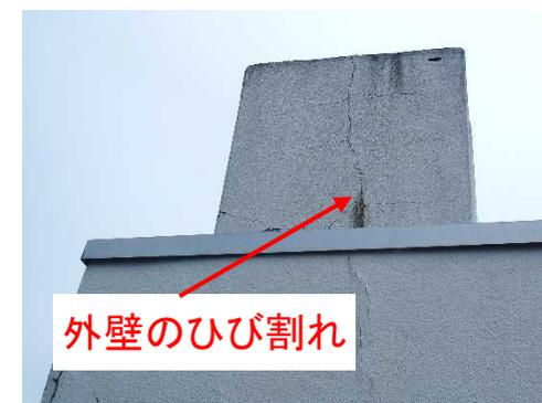
外壁：ひび割れが発生している
