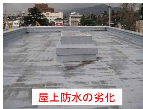
屋上(左)、天井(右)：屋上防水の劣化・剥離により、屋内天井に漏水痕が発生している
