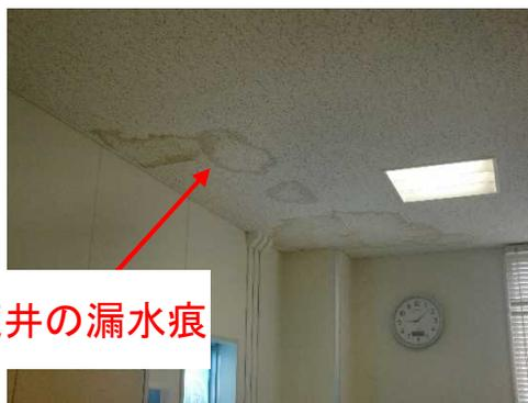
天井：外壁からの漏水により天井に漏水痕が発生している
