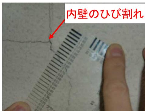
内壁：ひび割れが発生している
