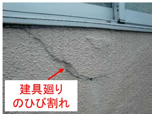
外壁：建具廻りの躯体にひび割れが発生している
