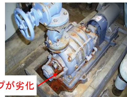
機械設備：空調用ポンプに発錆等の劣化が見られる
