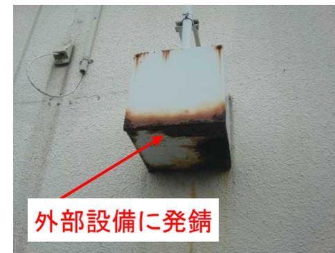
電気設備：外部プルボックスに経年劣化が見られる
