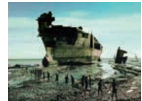
開発途上国における船舶解体の様子
