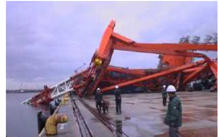
新潟港 事故状況
