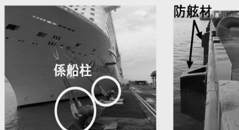
大型クルーズ船に対応した係船柱 ※2 ・防舷材 ※3 の設置
