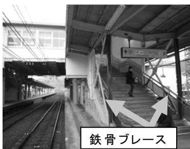
【橋上駅の補強】
