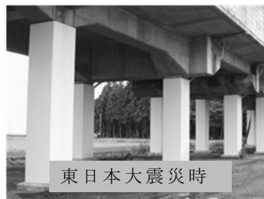
【高架橋の補強】
