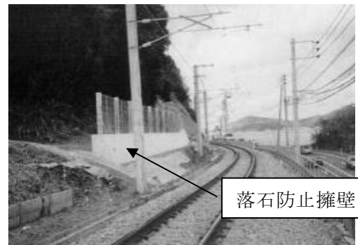
【落石防止擁壁の一例】
