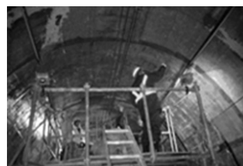
繊維シート貼付
