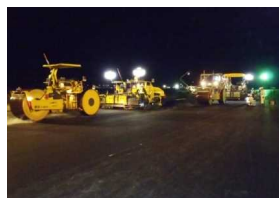
(老朽化した滑走路舗装の改良)
