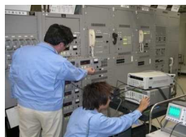
(航空保安施設点検実施状況)
