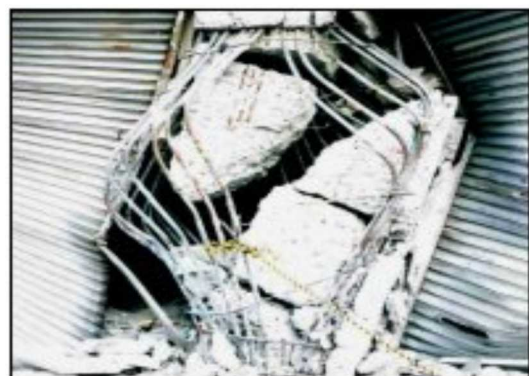
店舗1階柱の圧壊
