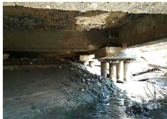
建物基礎が露出
