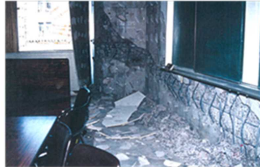
内部の被災状況
