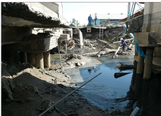
庁舎周囲の地盤流出
