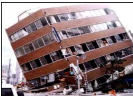
事務所ビル1, 2階の崩壊
