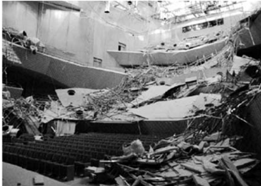
ホール天井の脱落
